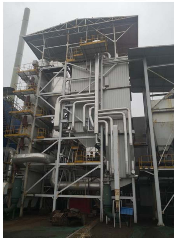
图4 燃煤多流程循环流化床锅炉
