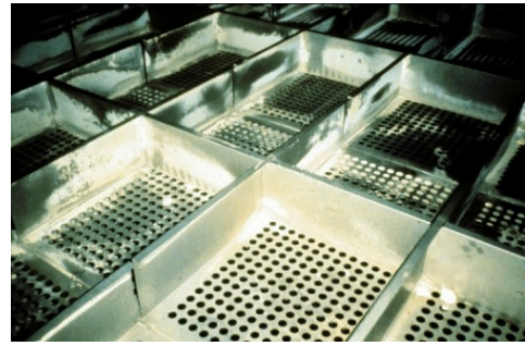
图 8 喷淋层下方的合金托盘
